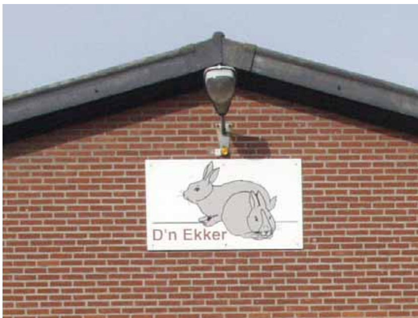
Het monitoringsysteem moet bestaan uit een systeem van gegevensuitwisseling tussen konijnenhouders, dierenartsen, mengvoerindustrie en slachterijen.
